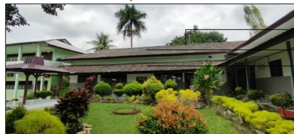
Foto Dokumentasi : Kondisi Atap Eksisting
