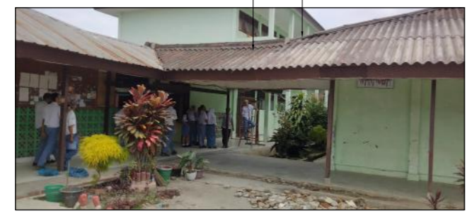
Foto Dokumentasi : Kondisi Atap Selasar Eksisting
