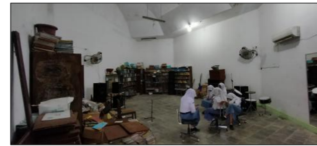
Foto Dokumentasi : Kondisi Lantai Gedung Perpustakaan
