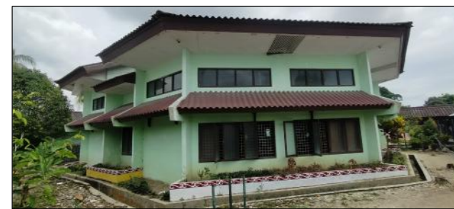
Foto Dokumentasi : Tampak Samping Kiri Eksisting
