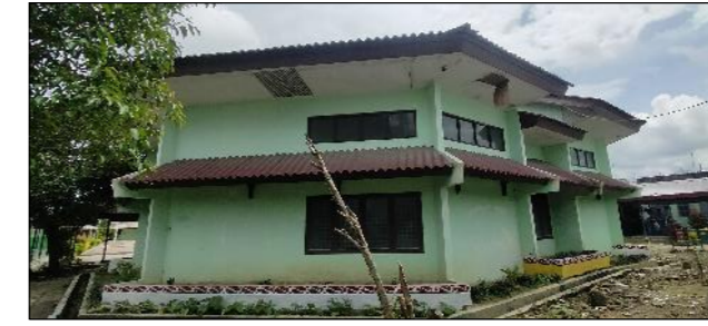
Foto Dokumentasi : Tampak Samping Kanan Eksisting
