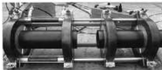
Gambar 3. 1. Proses Penyambungan Pipa
