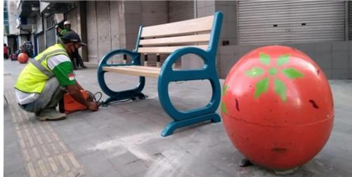
Gambar 8. Pemasangan dynabolt sebagai pengunci Bangku Taman Komposit dan lantai
